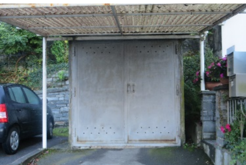
Magazzino Materiale Sbarramento
