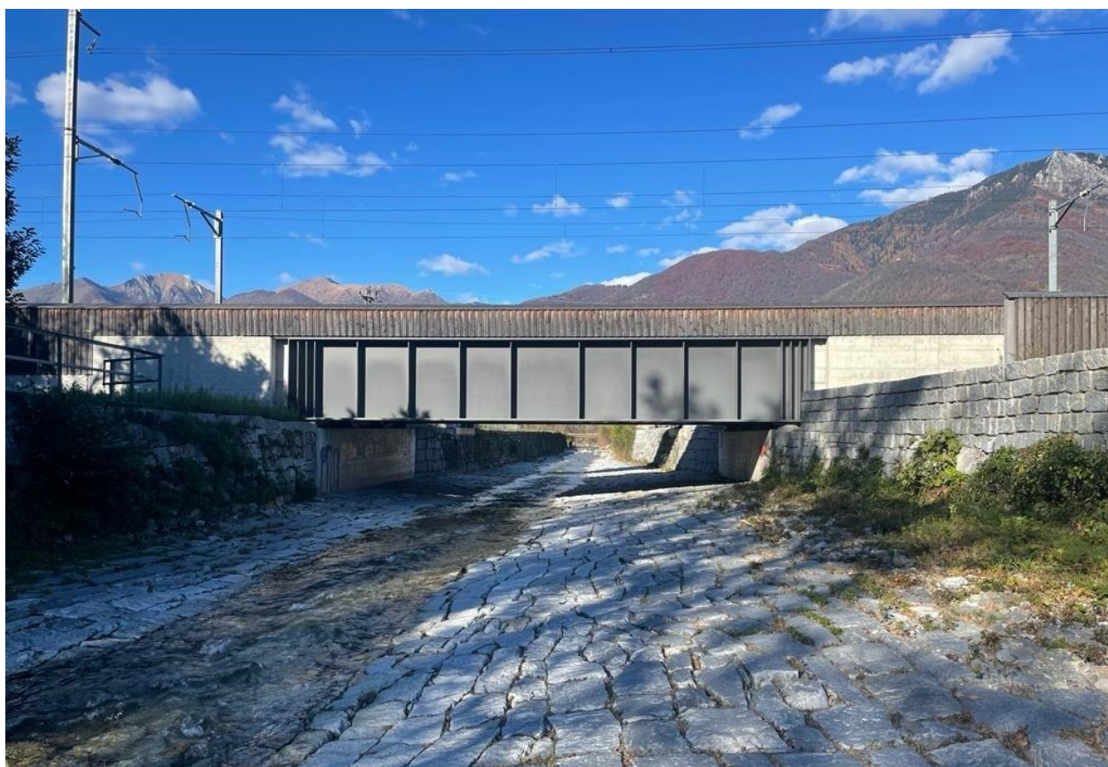
Il ponte originale è stato smantellato e sostituito in seguito dell'ammodernamento della ferrovia.
