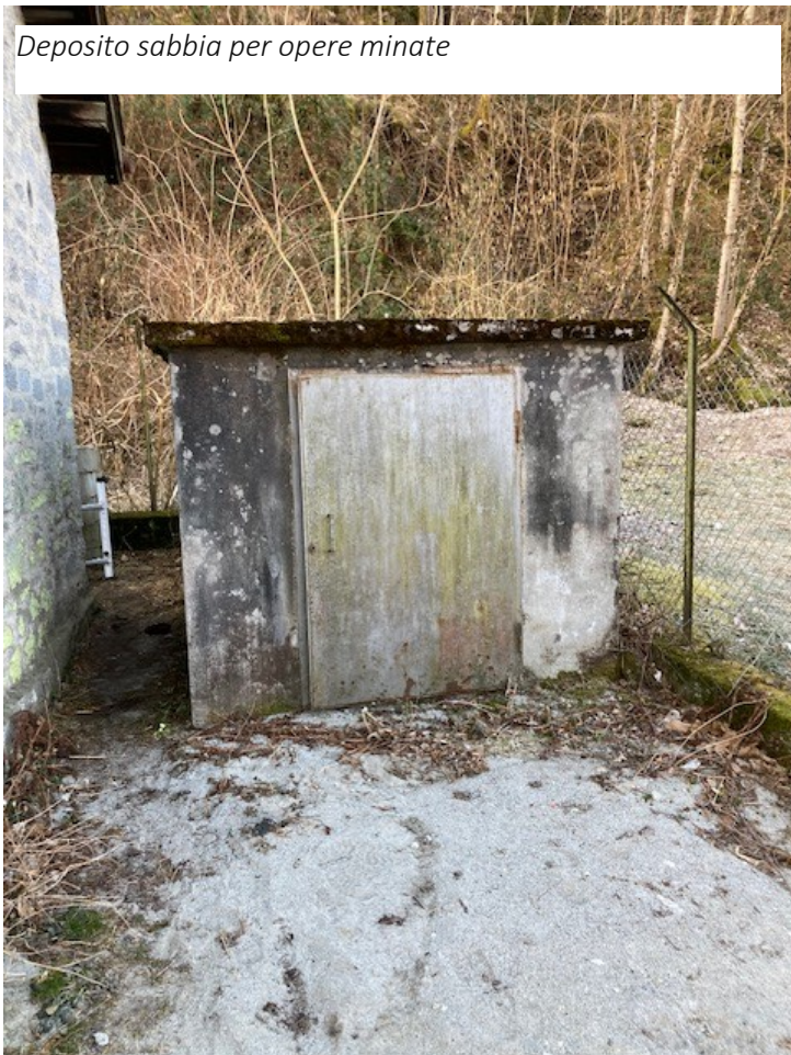
Deposito sabbia per opere minate
