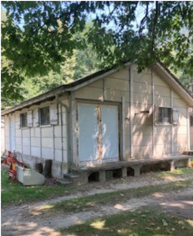
Baracca adibita ad accantonamento e ufficio
