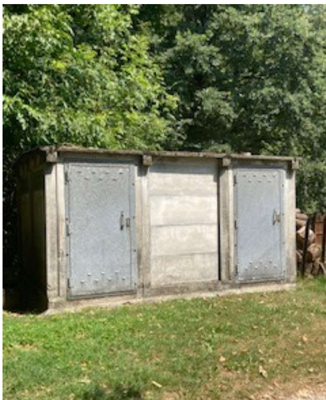
Baracca deposito carburante
